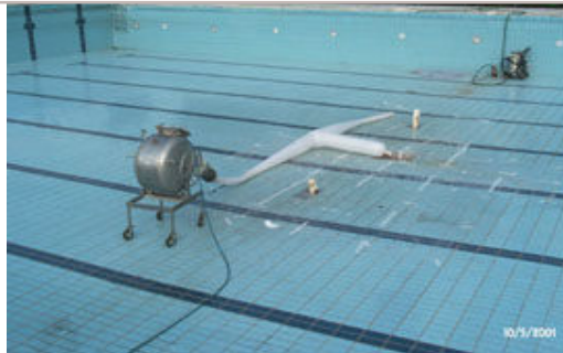
Guaina a "T" con cambio di sezione
